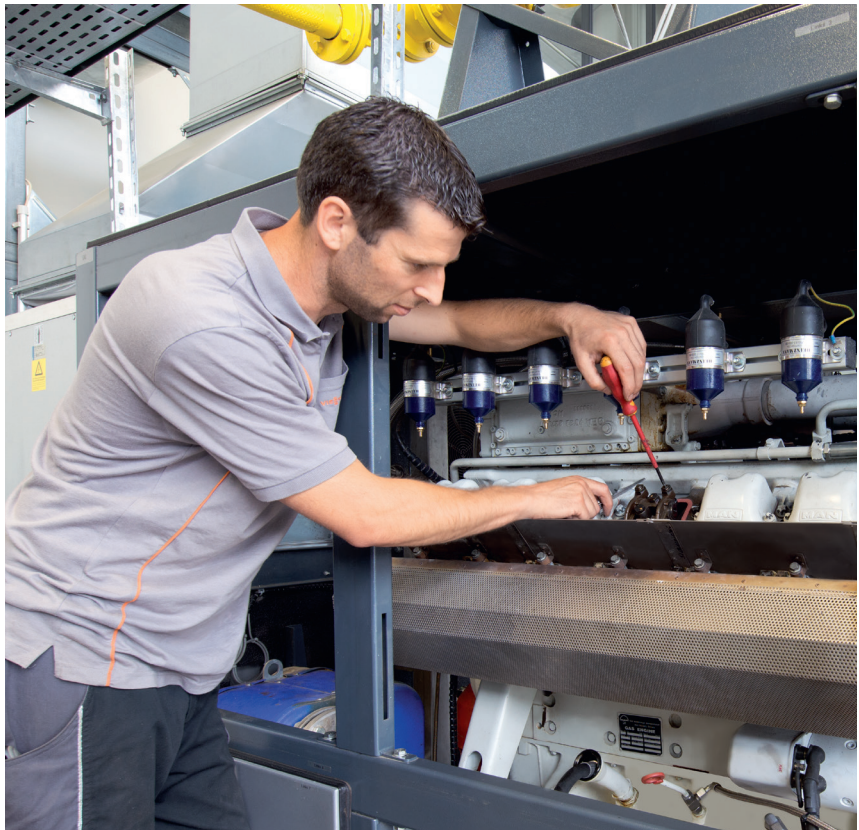
Viessmann Servicetechniker bringen umfassendes Know-how und viel Erfahrung mit – für einen reibungslosen Ablauf vor Ort.
